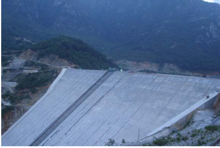
Resim 6.5: Elektrik üretiminde ve tarımsal arazi sulamasında kullanılan barajlar
